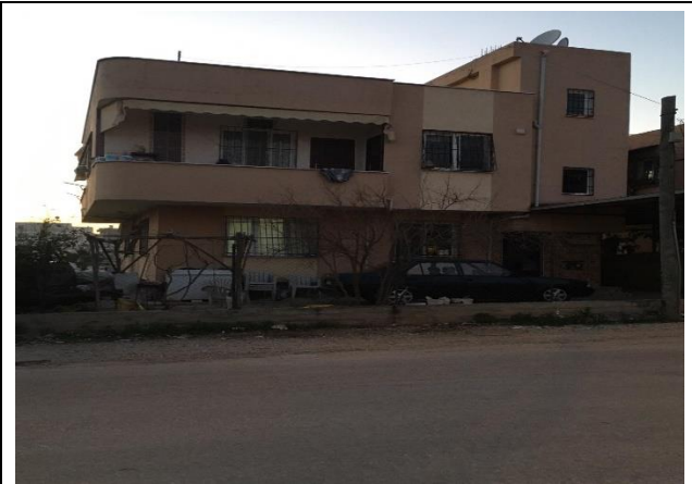
Fotoğraf 2. Kılıçlı Köyü'nde 10 Yıllık Betonarme Mesken
