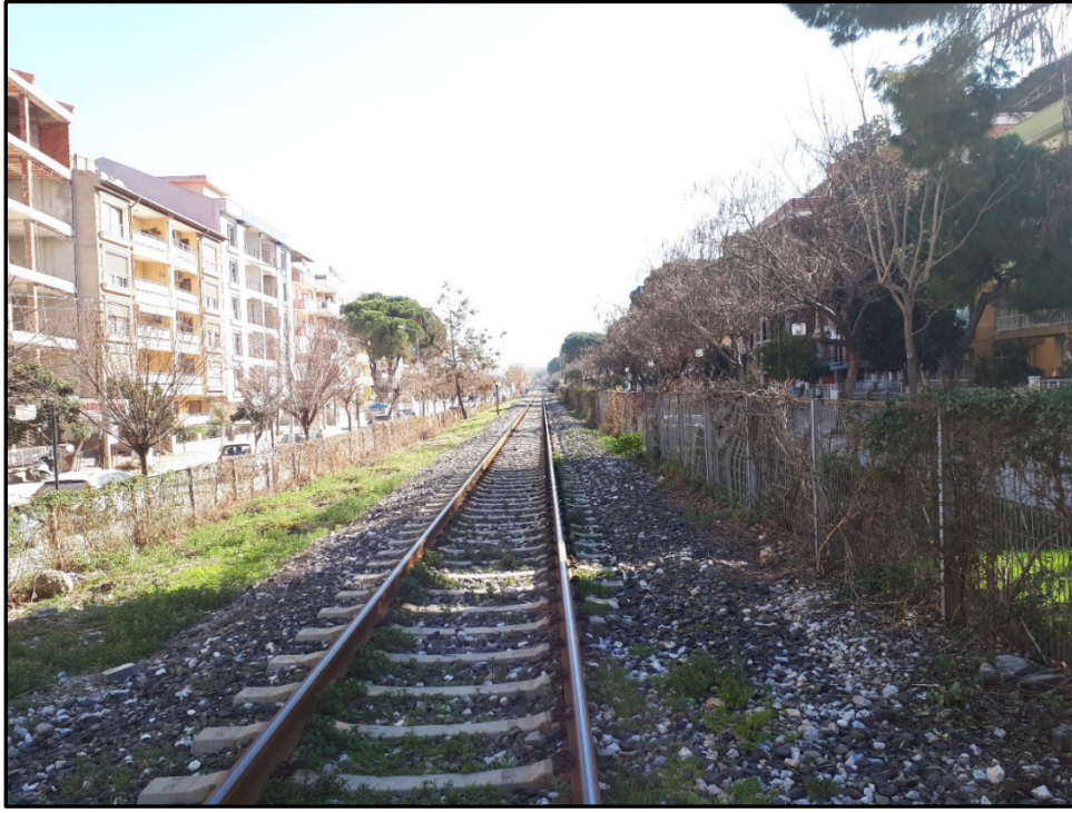
Şekil 8. Salihli şehrinden geçen demiryolu.
